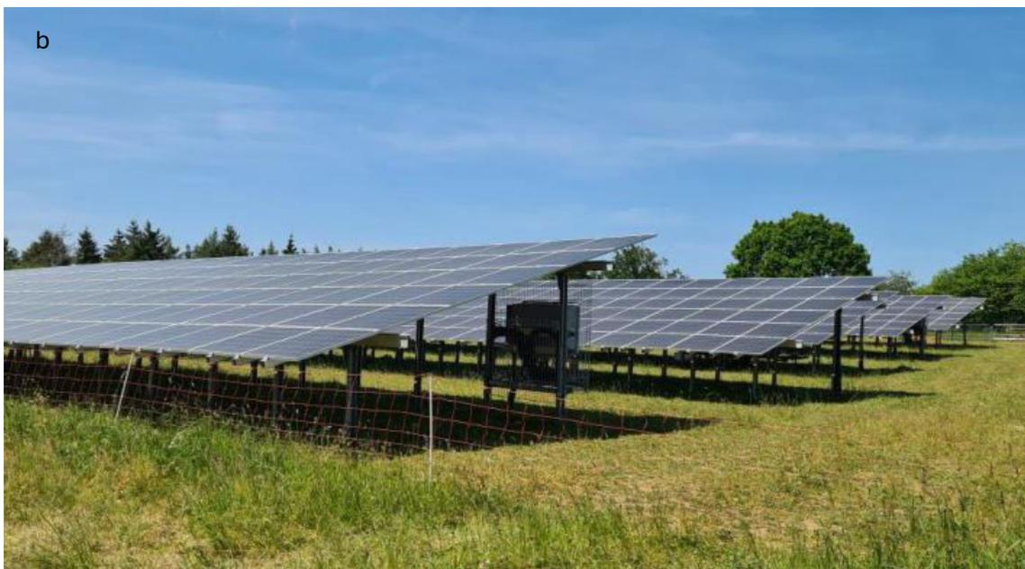
Abbildung 2: Beispiel einer Ost-West ausgerichteten Freiflächenanlage (a) und einer nach Süden ausgerichteten Freiflächenanlage (b) (Fotos: BGHplan)
