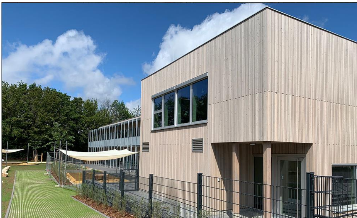
Abbildung 29 Eingangstrakt der neuen Kita am Estricher Weg mit Laubengang im Hintergrund. Foto Hochbauamt Trier
